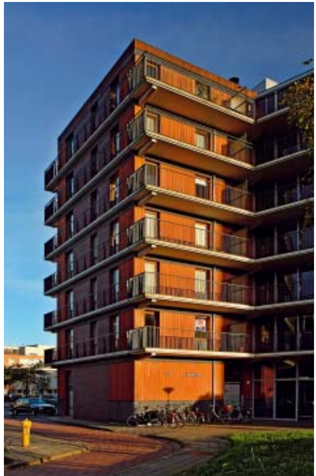
Boven 13 m hoogte geldt de zwaardere Euro-brandklasse B of NL-brandklasse 2, voor de eerste 2,5 m B of NL-brandklasse 1 en voor de vluchtwegen (open galerijen) C of NL-brandklasse 2. Woongebouw de Groene Haven Delft; ontwerp: KCAP Rotterdam.
